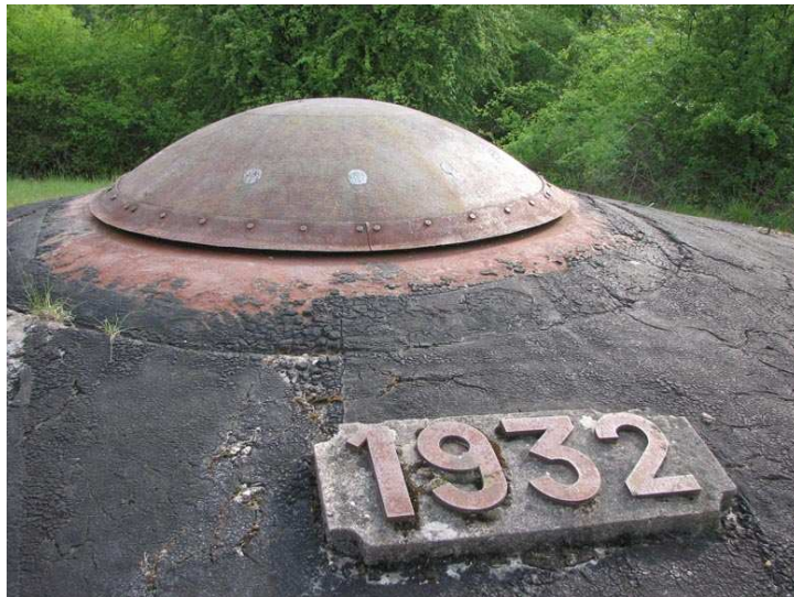
Une tourelle à éclipse de l'ouvrage du Hochwald , Bas-Rhin
