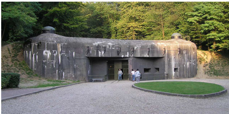
L'entrée des munitions de l'ouvrage de Schoenenbourg , Bas-Rhin
